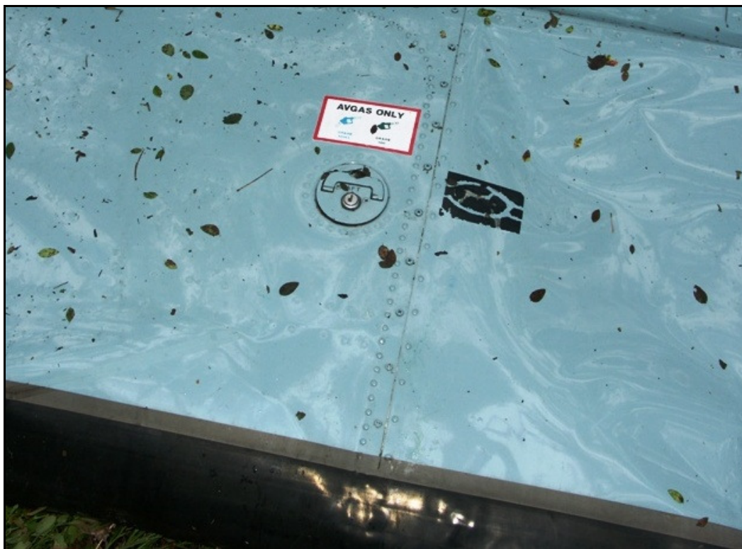
Fot. 20. Stan wlewu paliwa lewego skrzydła
