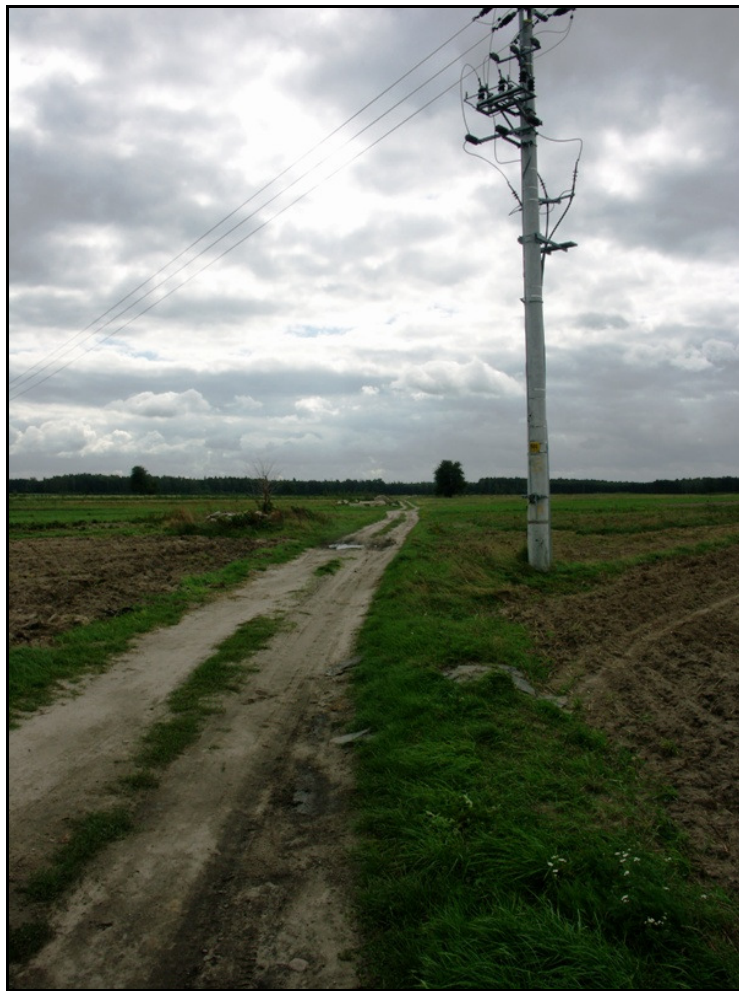
Fot. 27. Słup energetyczny w pobliżu, którego znaleziono fragment usterzenia poziomego
