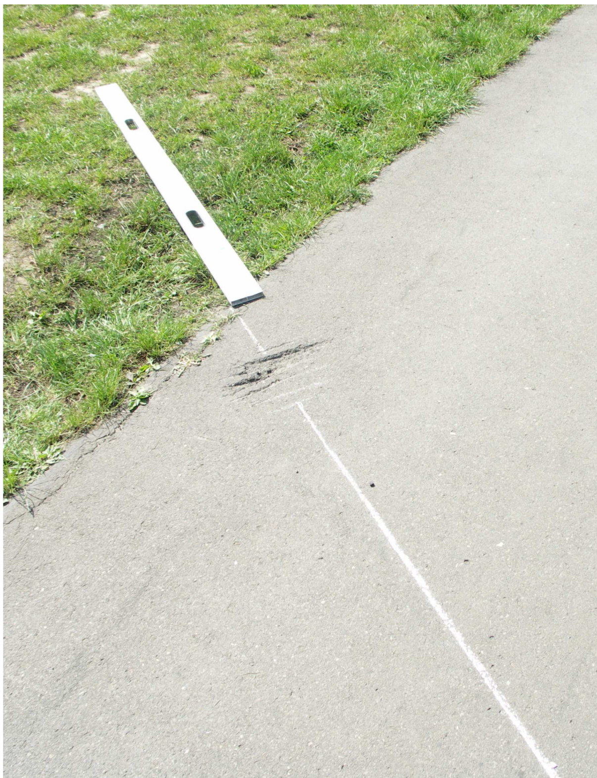
Fot.3 – Wyznaczenie linii kołowania samolotu przy bocznym skraju drogi kołowania.
