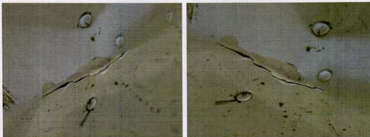
22 i 23 – Uszkodzenia lokalne dolnego pokrycia prawego skrzydła w pobliżu zniszczonej końcówki.
