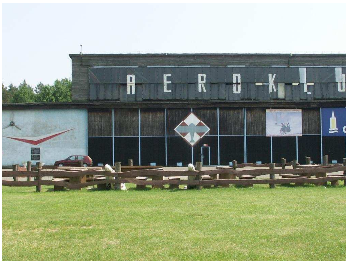
Widok na ogrodzenie ogródka gastronomicznego. Zdjęcie wykonane z kierunku przeciwnego do kierunku końcowej fazy lotu skoczka.
